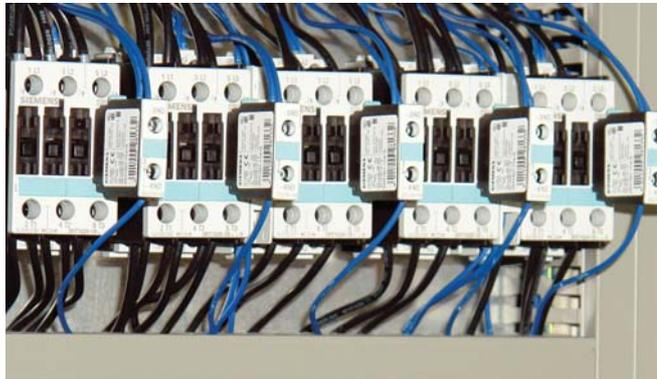
Nach wie vor wird der Stern-Dreieck-Anlauf zum Einschalten von Drehstrom-Asynchronmotoren verwendet. Bei dieser Schaltungsart reduziert sich der Anlaufstrom auf  $1/3$  des Stroms gegenüber dem bei Direkteinschaltung.
